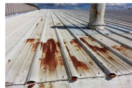
Конструкции птицеводческих помещений, как правило, имеют металлическую двускатную крышу из профлиста. Основными причинами протечек на таких кровлях являются коррозия металла, швы между листами профнастила, места крепежей и выходов на крышу элементов вентиляции.
