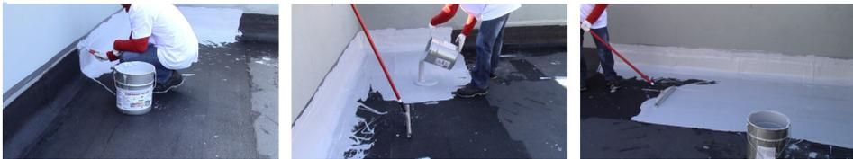
После отверждения покрытий образуется бесшовная, эластичная, водонепроницаемая мембрана, надежно защищая кровлю от протечек.
