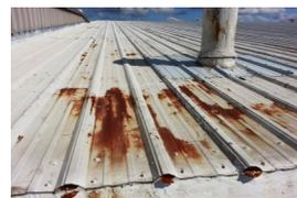
Конструкции свинарников и коровников, как правило, имеют металлическую двускатную крышу из профлиста. Основными причинами протечек на таких кровлях являются коррозия металла, швы между листами профнастила, места крепежей и выходов на крышу элементов вентиляции.
